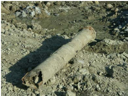
Druckleitung ab Zwischenspeicher
