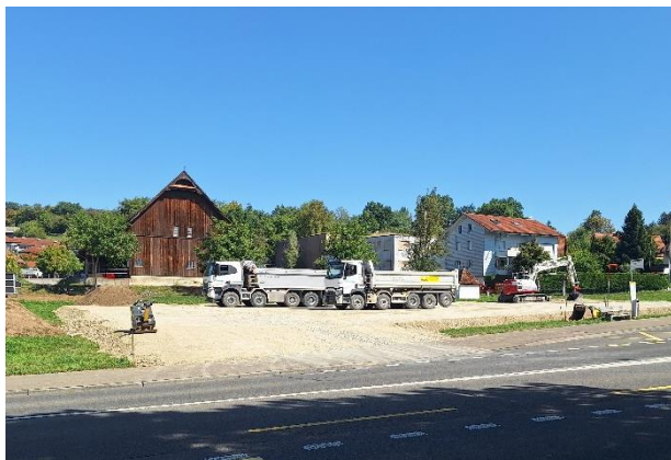
Installationsplatz Bauarbeiten Schauensee
